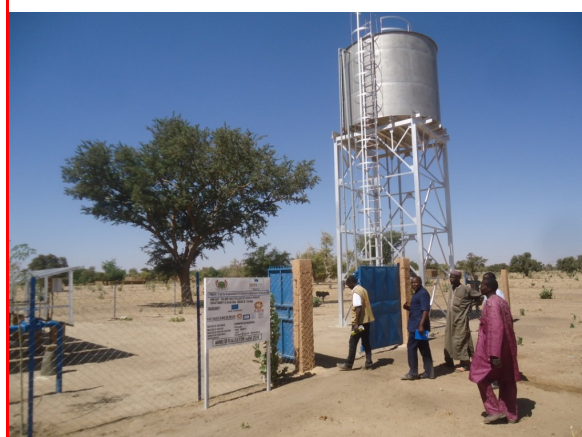
Vue d'un château d'eau des Mini adduction d'eau potable réalisés avec l'appui de CARE
